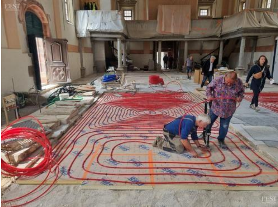
Pose des serpents du futur chauffage au sol (géothermie), mardi 8 juillet, avant le coulage de la chape. Photo Alexandre Bollengier
